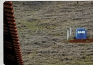
Reservatório da elevatória - Otto L. Hoffmann
