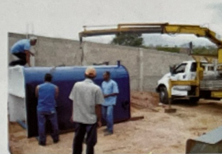
Obras da ETA de Itaimbé
