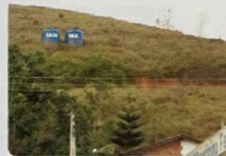
Reservatório da elevatória - São José
