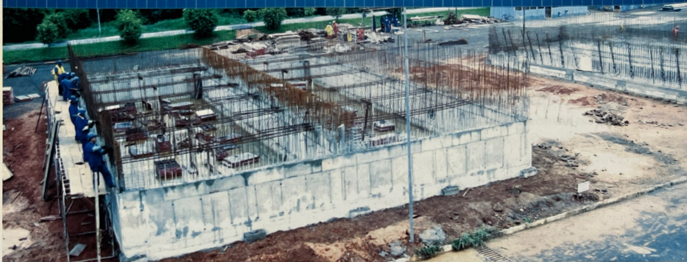
Obras para os novos reatores da Estação de Tratamento de Esgoto Principal
