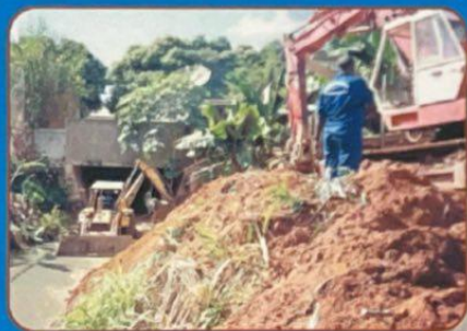
Ações de saneamento ambiental: retirada dos pontos de lançamento de esgoto e instalação dos interceptores.
